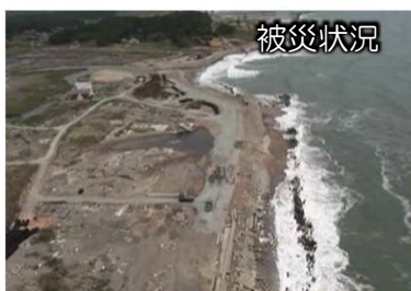
木崎地区海岸（新地町）
