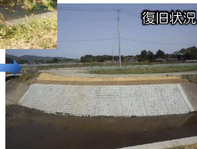
②令和5年台風13号の復旧状況
