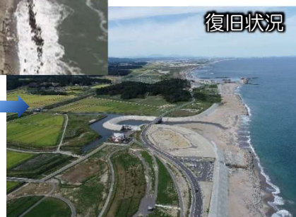
①東日本大震災の復旧状況
