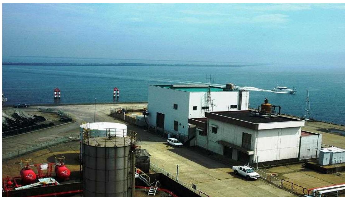
【小名浜ポンプ場】
