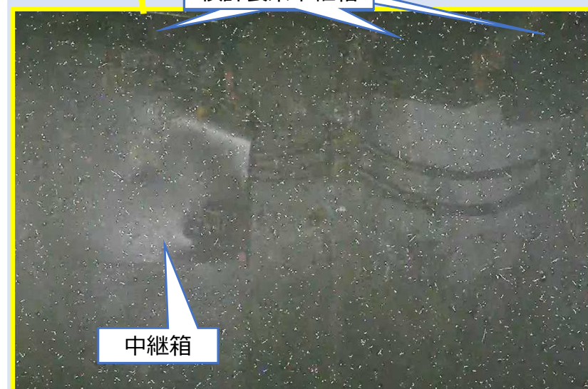
ペDESTAL内中継箱の状態(左：0°付近、右：180°付近)
