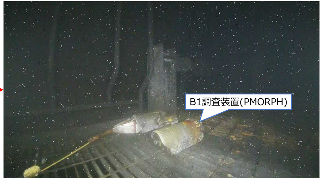
写真1.北側B1調査装置(PMORPH)の残置状況
