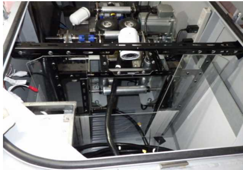
ガードパネル取付け後
