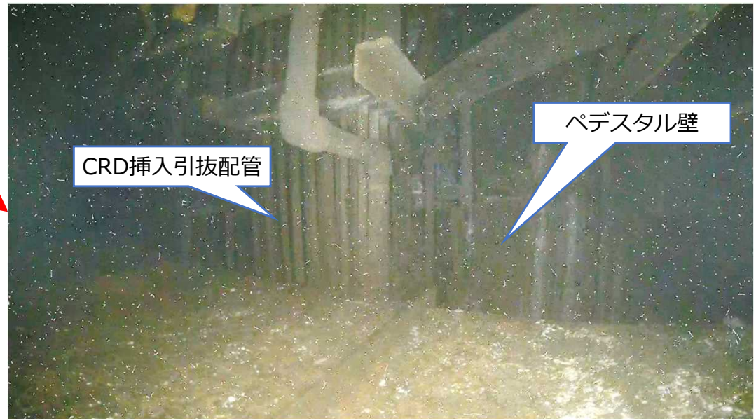
写真2.CRD挿入引抜配管の状況
