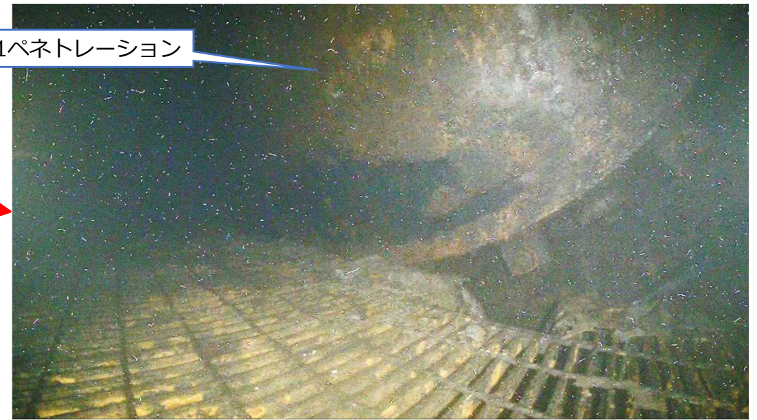
写真1.X-1ペネトレーションの状況
