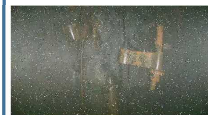
⑨：落下した構造物 C
