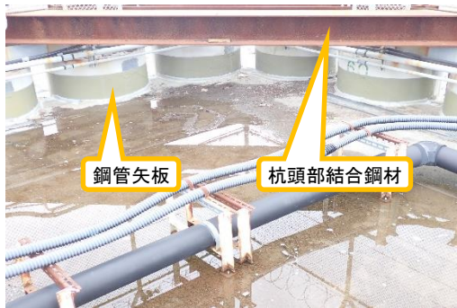
(写真1) 最北端コーナー部の海側遮水壁 鋼管矢板の設置状況
