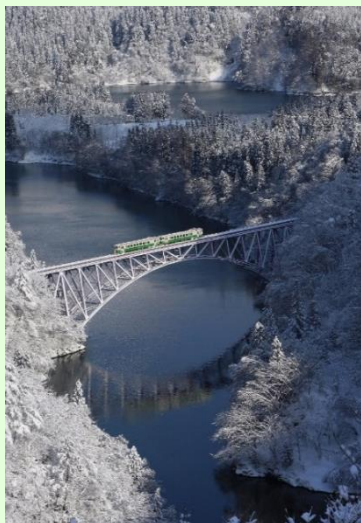
第1只見川橋梁
