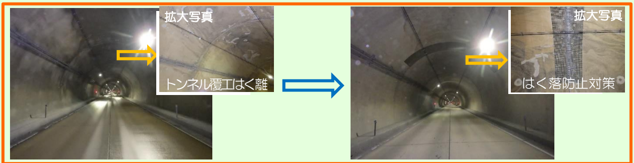
柳津昭和線 湯八木沢トンネル（柳津町）
