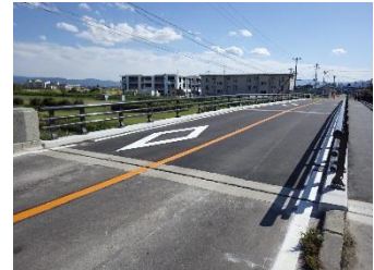
③補修施工を行い完了
