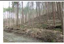
間伐・丸太筋工
