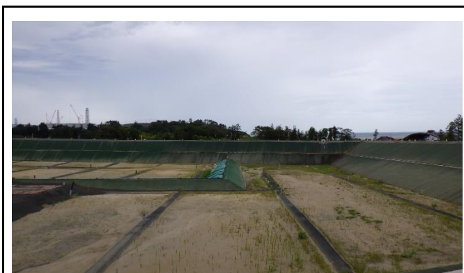
土壌貯蔵施設の状況
