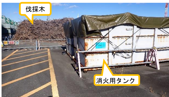
(写真 3 - 1) 消火用タンクの設置状況
