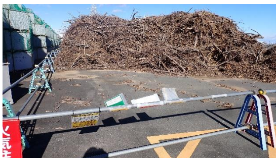
(写真 4) 単管パイプによる区画の状況
