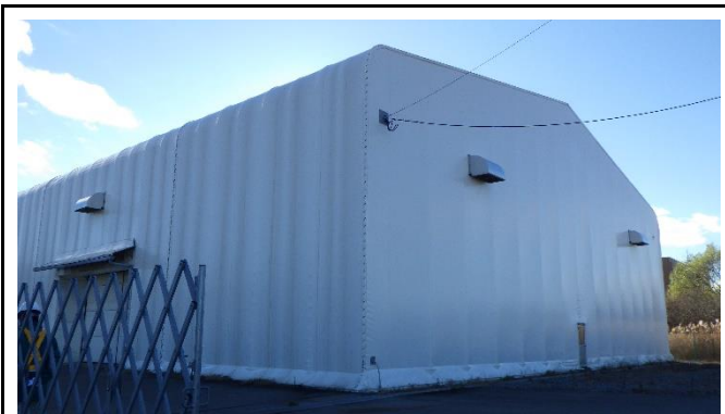
保管テント外観 異常なし。
