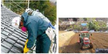
▲ Khu nhiễm nhà ở (loại bỏ đất đá mảnh vỡ) ▲ Khu nhiễm đất nông nghiệp (cây bầu đất sâu)
