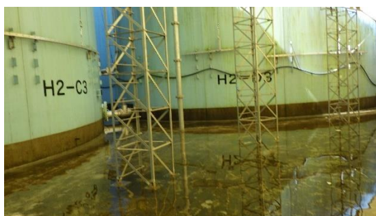
(写真7) 堰内の雨水滞留状況
