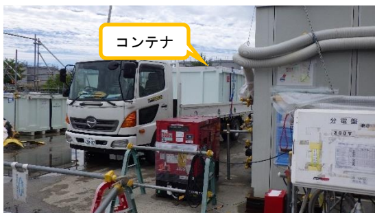
(写真4) スラッジを収容した金属製コンテナ を積載したトラックの状況
