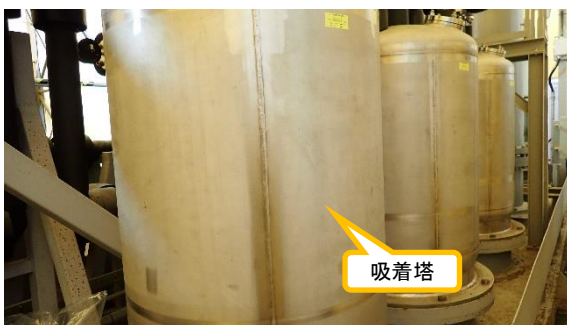
(写真 3 - 2) 浄化ユニットB系の設置状況②
