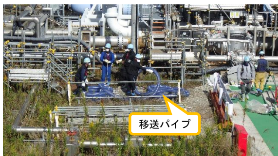
(写真 1－1) 移送パイプの設置状況①
