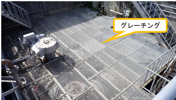
(写真 2 - 2) 移送先のピットの状況 ※グレーチング（金網の蓋）の下部 に水が移送される。
