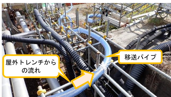
(写真 1－2) 移送パイプの設置状況②
