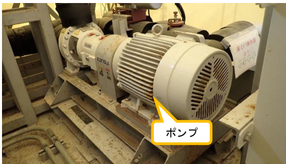
(写真 3 - 1) 浄化ユニットB系の設置状況①
