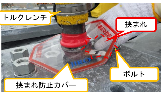
(写真 4 - 2) 負傷者発生時の状況及び対策① ※発生時挟まれ防止カバーは取り付けられていない
