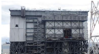
1号機の大型カバー 設置の様子
