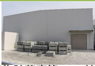
固体廃棄物貯蔵庫第10-C棟の外観 (出典: 東京電力ホールディングス)
