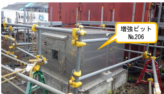
(写真 4 ①) サブドレンピット No. 206 (増強) の状況① (移送配管・電装ケーブルは未接続)
