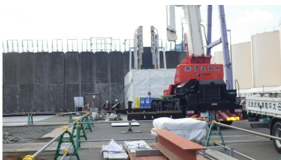
(写真 1－1) 使用済セシウム吸着塔一時保管施設 (第三施設) 北側増設工事の状況① (H I C吊り上げのシャフト改造作業)
