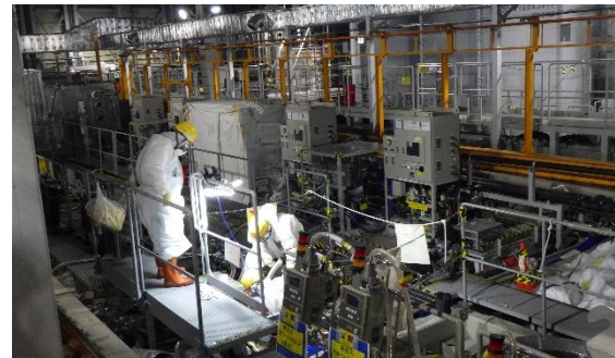
(写真3-2) 増設ALPS建屋内の メンテナンス作業② (アンカー打 設)
