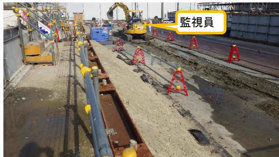
(写真 5) アスファルト撤去作業
