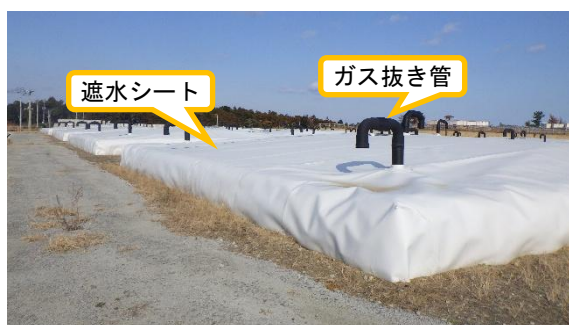
（写真1①）一時保管槽の設置状況
