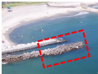
施工前（R7年7月）
