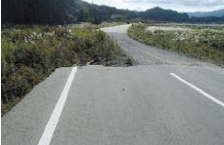
県道広野小高線の仮復旧状況
