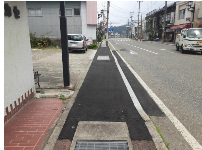
R7工事完了後
