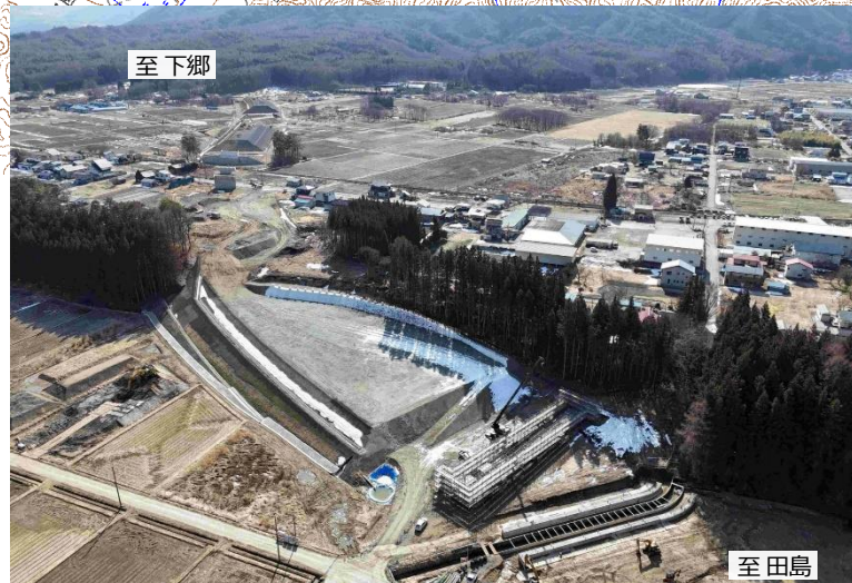
南会津町櫃ヶ島地区(道路改良(盛土)・函渠工施工状況)
