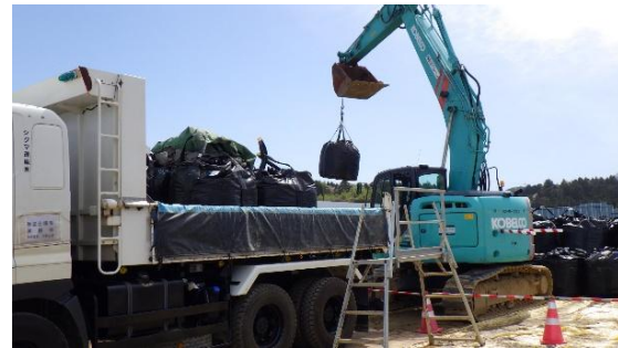
積込作業の状況
