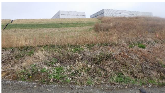
(写真4⑤) エリア北側
