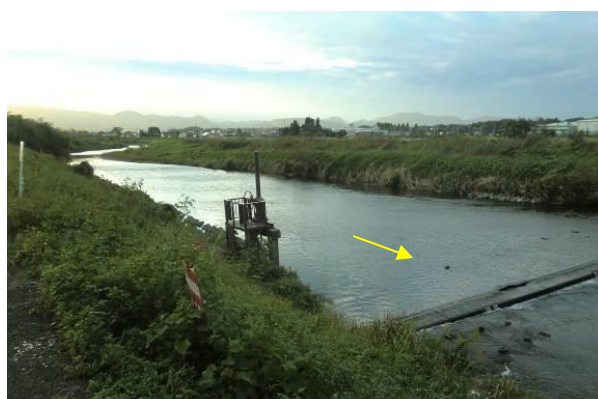
写真－3 宇多川下流部（国道6号橋上流）
