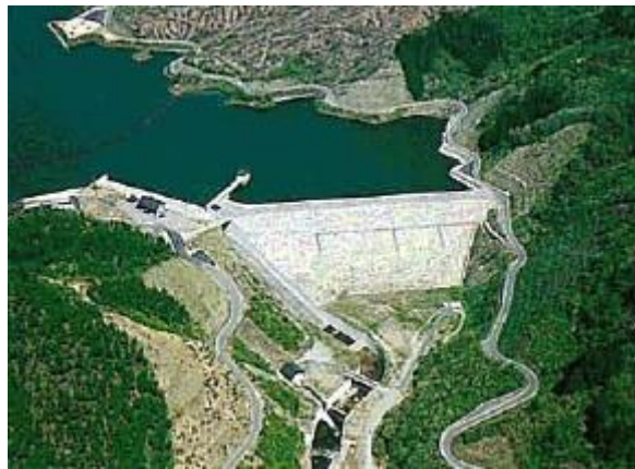
写真－6 松ヶ房ダム 6
