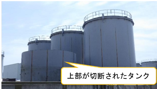
(写真2) J8タンクエリアにおける タンク解体状況
