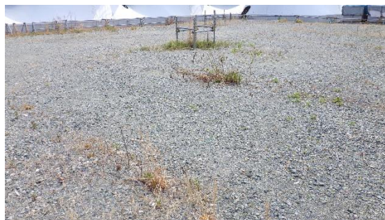
(写真1-2) 地下貯水槽No. 6の地上部の外観
