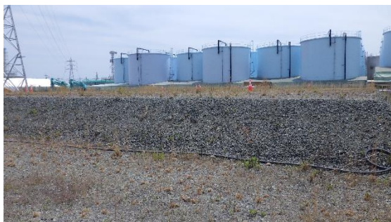
(写真1-1) 地下貯水槽No. 3の地上部の外観
