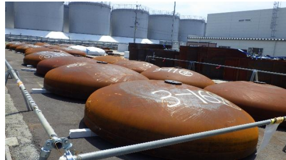
(写真3) J9タンクエリア(タンク解体後の敷地)における横置きタンク解体片の保管状況
