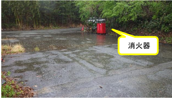
(写真 3 - 1) 消火器の設置状況
