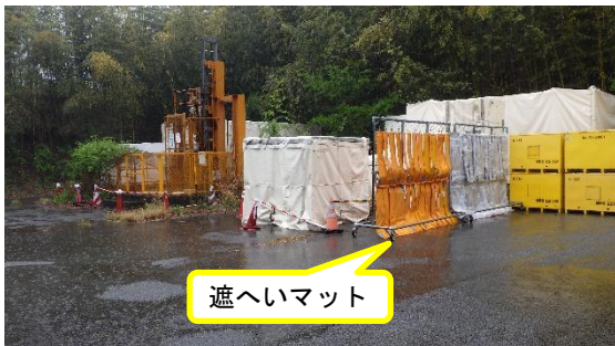
(写真 2 - 1) 一時保管エリア E 2 の状況① (西側)
