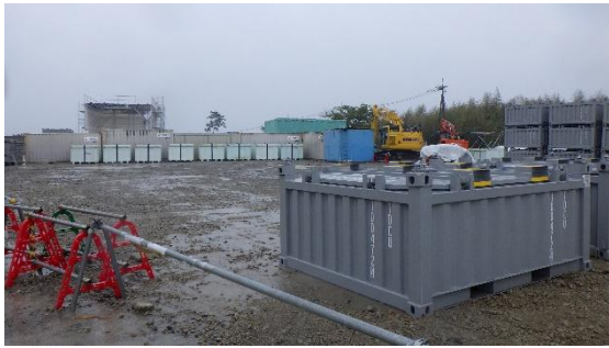
(写真 1 - 2) 一時保管エリア E 1 の状況② (南側)
