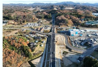
国道288号(船引) R8.3.28供用
