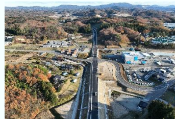
国道288号(船引) R8.3.28供用
