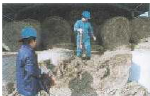
② ヘイカッターで解体する
