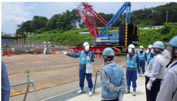
(写真 5) 固体廃棄物貯蔵庫第 11 棟の状況 ※建設工事の進捗状況を確認した
