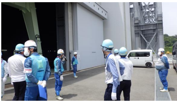
(写真 6) 大型廃棄物保管庫第一棟の状況 ※耐震工事の実施状況を確認した
