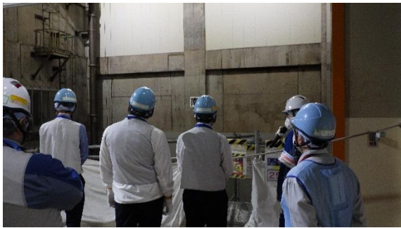
(写真 3) 増設雑固体廃棄物焼却設備の状況 ※水蒸気発生事象後の復旧状況を確認した
