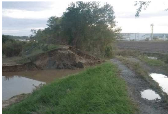
図 1.17 令和元年東日本台風の浸水状況 谷田川破堤箇所（2.5km 左岸）
