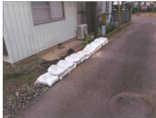
図 13.7 土のうの設置（郡山市）
