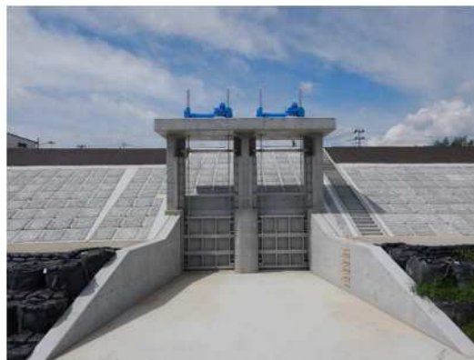
石塚排水樋門（大河原排水区）
