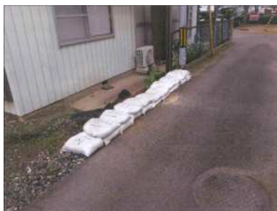
図 13.7 土のうの設置（郡山市）
