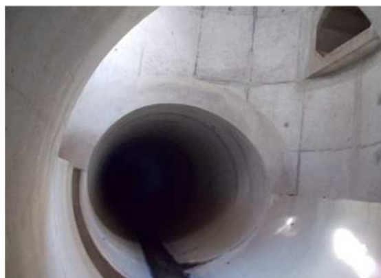
3号幹線増補管の内部（郡山駅前地区）
