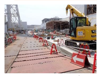
フェーシング前 (3号機付近)
