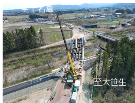
県道上名倉飯坂伊達線 天戸橋工区
