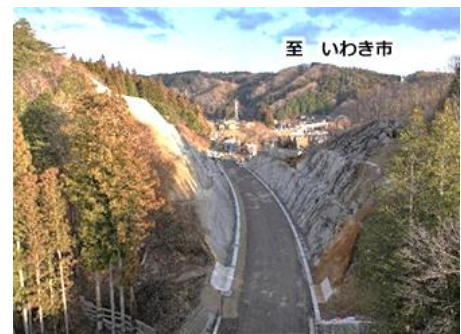
いわき石川線1工区（道路改良工事）
