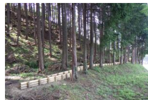
間伐・丸太筋工
