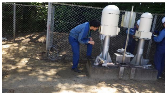
(写真6－4) モニタリングポスト No. 4における保守点検作業の状況
