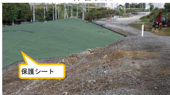
(写真 3 - 1) 道路側へ火災防止用 保護シート敷設状況
