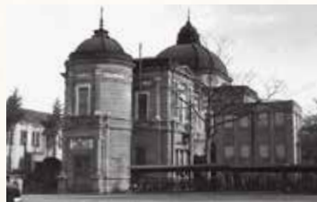
東京国立博物館のドームを模した重厚な建物（提供／福島市）
