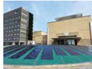
Jヴィレッジの湾曲形状の地面（芝生）に設置したペロブスカイト太陽電池（楡葉町）
