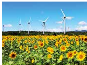
郡山布引高原風力発電所
