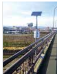
簡易型河川監視カメラ (瀬川・福島市)
