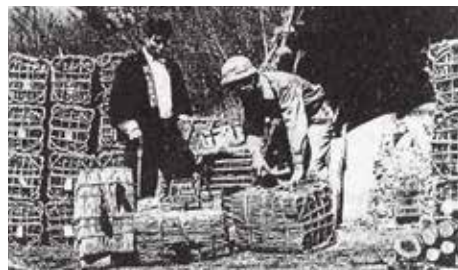
木炭の県営検査の様子 (15kg俵に製炭された木炭を精練計により1俵毎に検査する)
