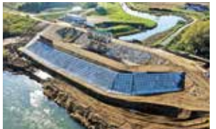
須賀川市浜尾地区 緊急復旧工事状況 (堤防決壊から一月以内の11月8日に完了) (提供／福島河川国道事務所)
