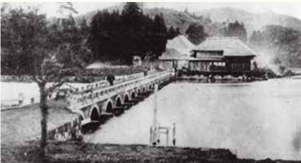
安積疏水開削当時の十六橋水門（提供／郡山市）
