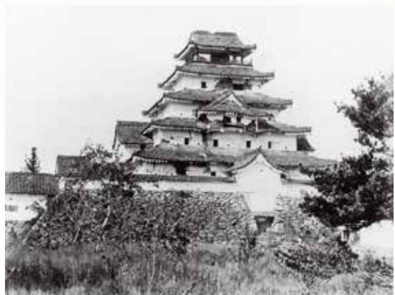
損傷した会津戦争後の若松城（提供／会津若松市）
