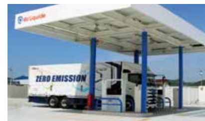
本宮インターチェンジ水素ステーション（本宮市）
