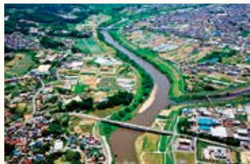
郡山地区、逢瀬川との合流地点の阿武隈川（提供／福島河川国道事務所）
