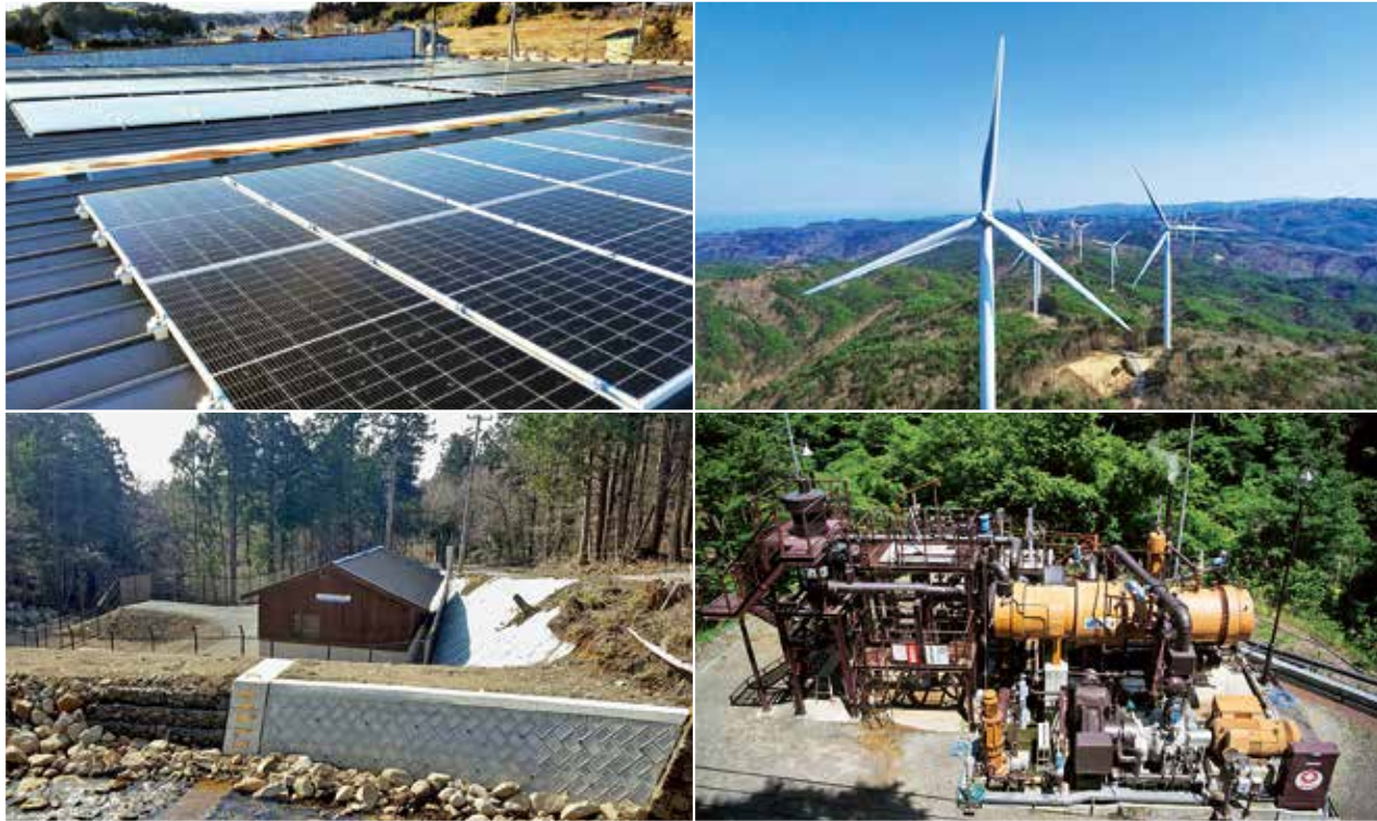
写真左上 補助金を活用した太陽光発電導入事例（田村市） 写真右上 阿武隈風力発電所（田村市・大熊町・浪江町・葛尾村） 写真左下 信夫山・遠藤ヶ滝・大玉第一小水力発電所（大玉村） 写真右下 土湯温泉16号源泉パイナリー発電所（福島市）
