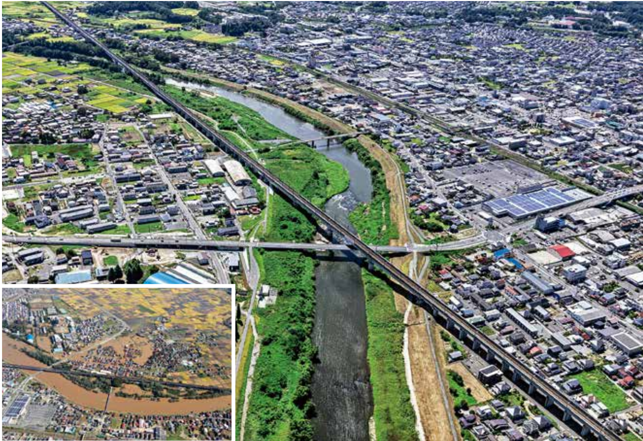
令和元年東日本台風による郡山市徳定・御代田地区の浸水被害 (国土地理院撮影／令和元年10月13日)
