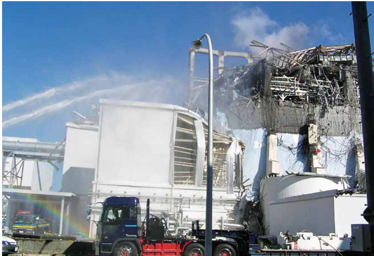
東京電力福島第一原子力発電所3号機への放水作業（大熊町）
