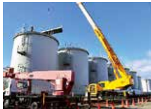
処理水タンク解体に着手する様子(提供：東京電力)
