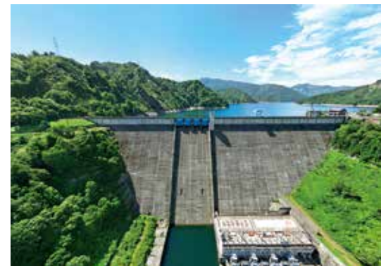
田子倉ダム (提供/J-POWER田子倉電力所)
