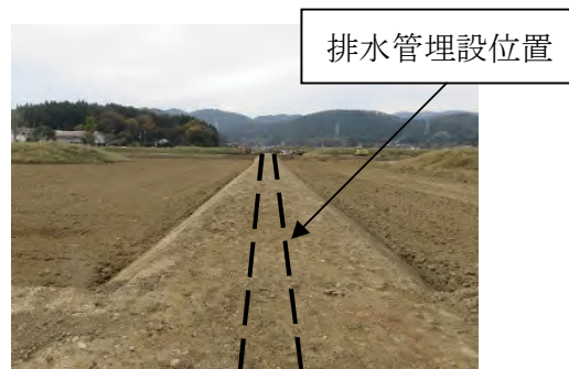
(完了状況) (いわき市)
