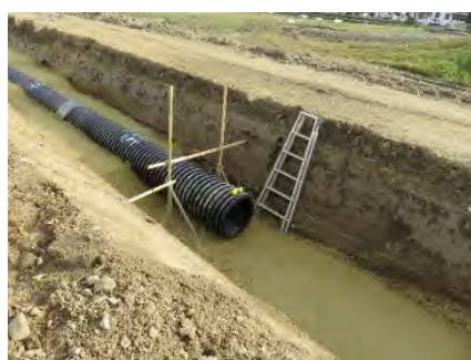
瀬戸地区における排水路暗渠化工事 (排水管布設状況)
