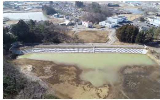
防災工事施工後 （同地区）
