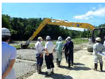
直接掘削による除去工 (県営モデル事業の研修会の様子)
