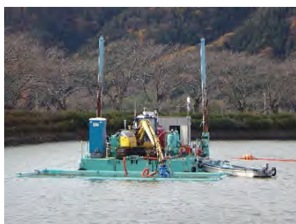
浚渫による除去工
