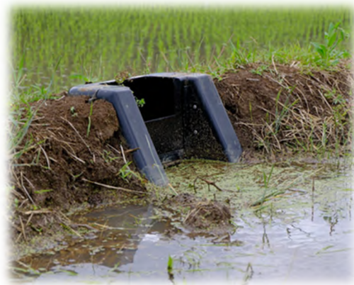
畦畔に設置した堰板
