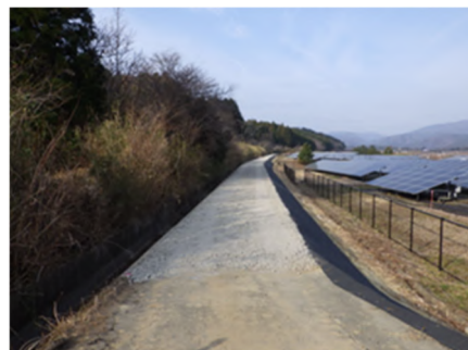
施工後 (水路法面)防草シート (管理道路)道路改良工(セメント系)
