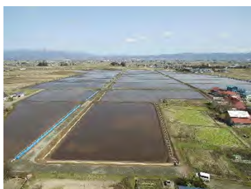
「完成した梁田地区」
