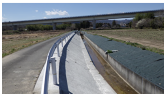
シーリングコンリート工及び防草シート工
