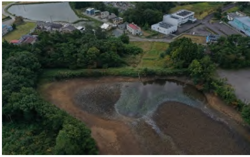
防災工事施工前 荒池地区（大玉村）
