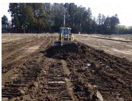
区画整理工事に着手 (南相馬市鹿島区 山下地区)
