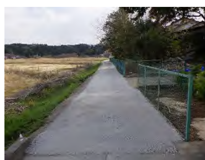
道路改良工(セメント系)
