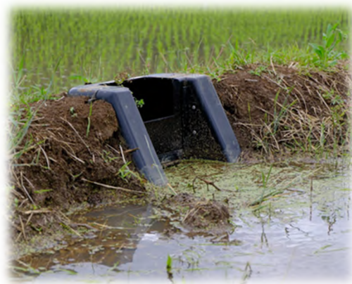
畦畔に設置した堰板
