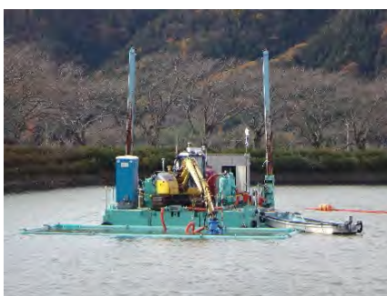
浚渫による除去工
