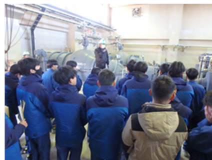
大越藤間第二排水機場
