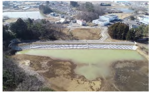
防災工事施工後 （同地区）
