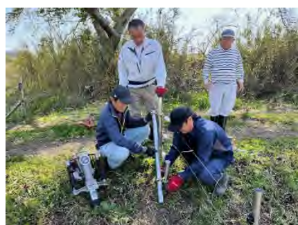
恒久電気柵設置 (令和7年4月21日)
