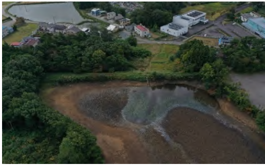
防災工事施工前 荒池地区（大玉村）
