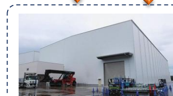
固体廃棄物貯蔵庫
