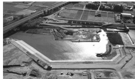
新沼部堰全景(下流に建設中)
