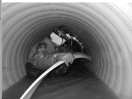
【人孔間耐震工事】
