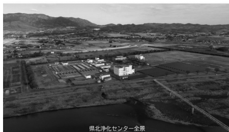
【県北浄化センター】
