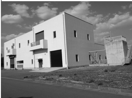
【第2スクリーンポンプ棟】
