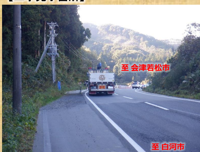
【工事完了箇所】
