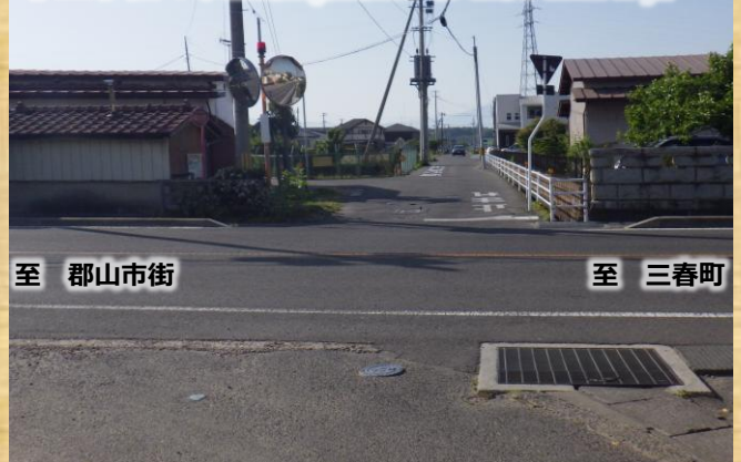
【 工事前：終点側(南側から北側を望む) 】
