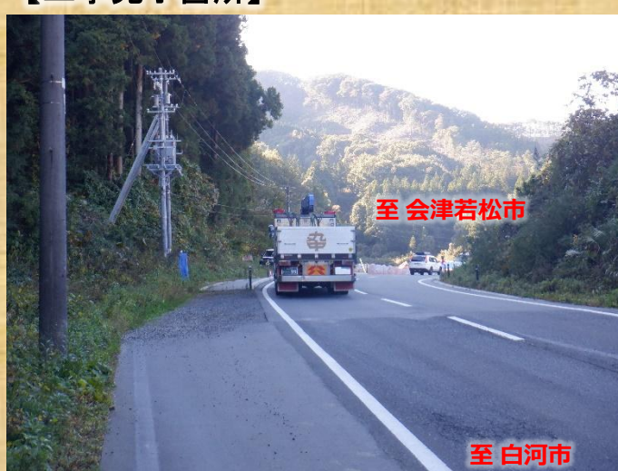
【工事完了箇所】
