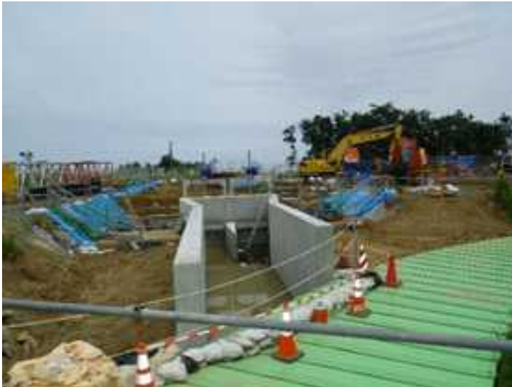
○ B・C排水路付け替え 排水路ゲートの設置状況
