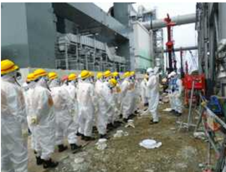
○凍土遮水壁工事現場の 確認 4号機R/B南付近 (8BLK)
