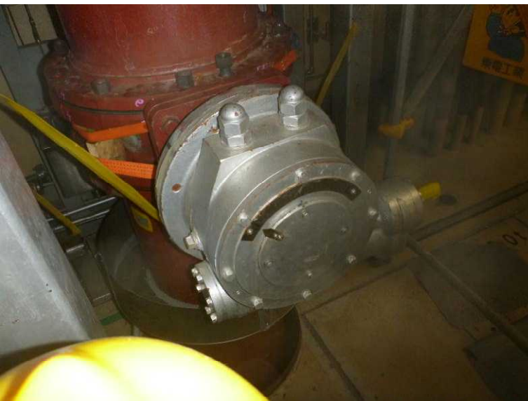
○5号機補機冷却海水系 RCW熱交換器出口 調整弁 (V-37-91B) の 応急処置状況
