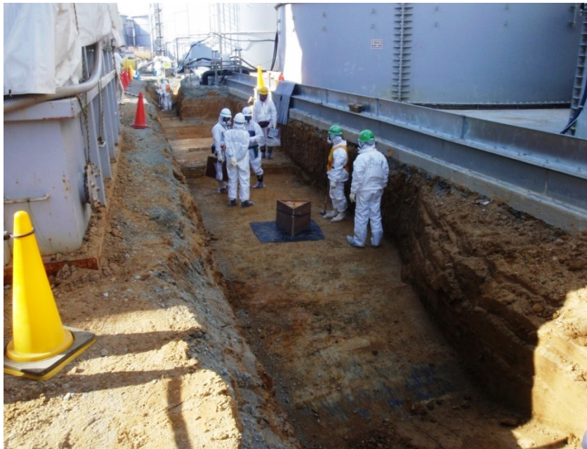
掘削部分の全景
