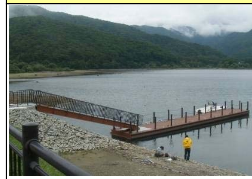
桧原湖北岸棧橋整備（北塩原村）
