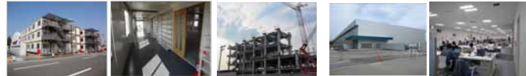
仮設休憩所と建設中の大型休憩所
