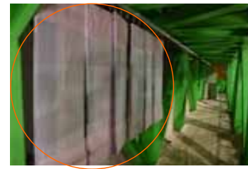
4号機燃料交換機への遮へい体設置の様子
