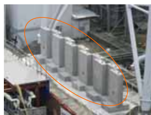
1 / 2号排気筒近傍の遮へい体設置の様子
