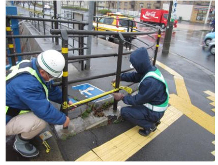
応急補修作業
