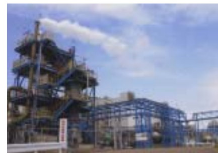
直江津工場・リサイクルシステムの燃焼設備(左手前)と回収設備(右奥) 排ガス、排水から塩水を回収し、原料として活用する画期的な新システムへの開発投資を実施し、2005年7月から本格稼働を開始しました。 (燃焼設備の煙突から出ているのは水蒸気です)
