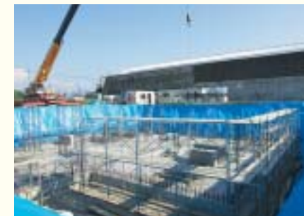
増設工事中の排水処理設備
