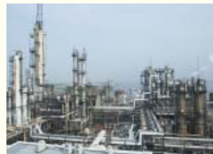
工場北側は大阪湾に接しています。石油コンビナートの一員として、設備の安全監視とともに環境管理も重要な取り組みです。
