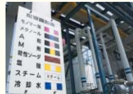
工程内には多くのパイプラインが走っています。人にやさしい配管識別表示に取り組んでいます。
