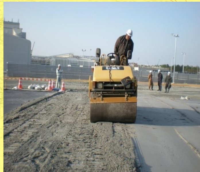
タイヤローラによる撒出し施工
