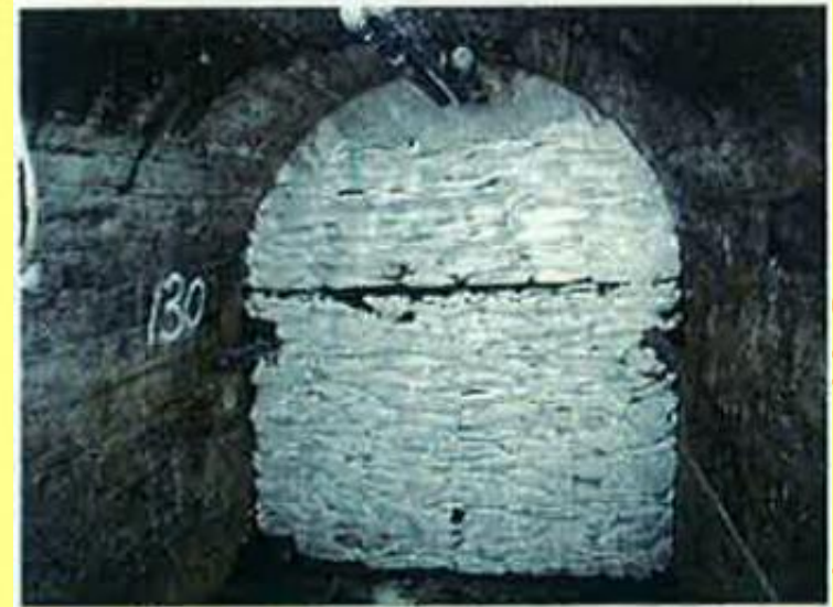
排水路トンネル閉塞工
