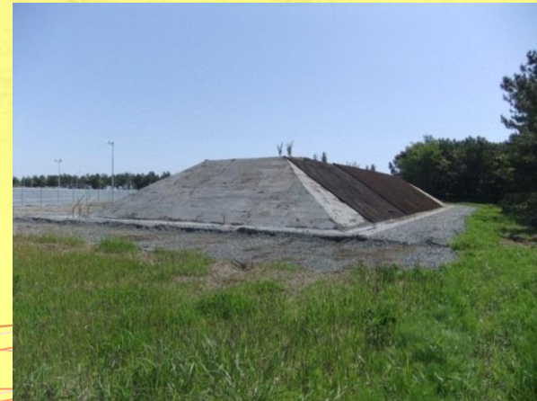
ソマッシュによる防潮堤盛土
