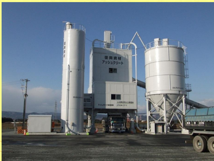
製造プラント全景(新地発電所構内)
