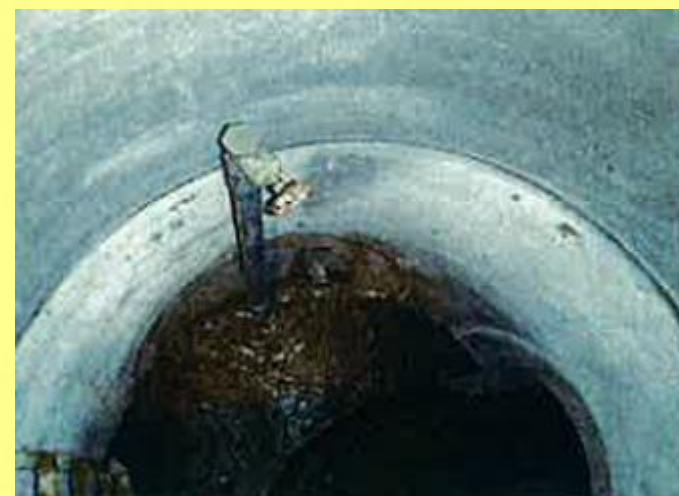
残置管閉塞工
