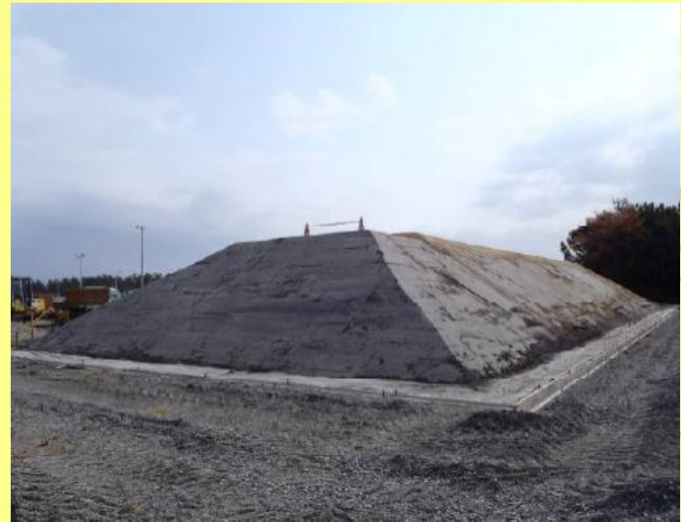
防潮堤盛土の完成
