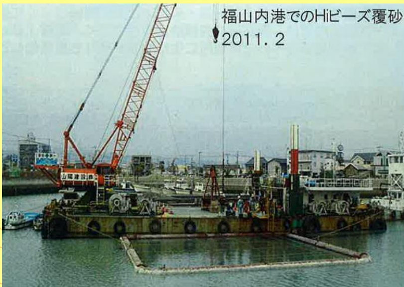
Hiビーズの敷設作業(覆砂)
