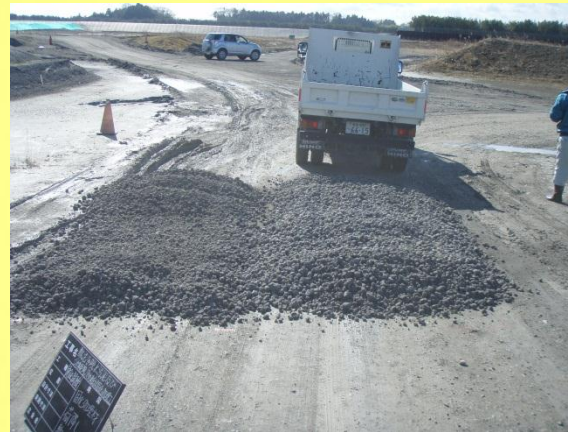
28日養生後、道路の路盤材として敷均し転圧
