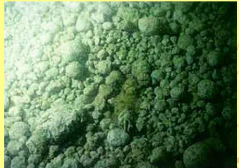
海底に敷設されたHiビーズ覆砂状況
