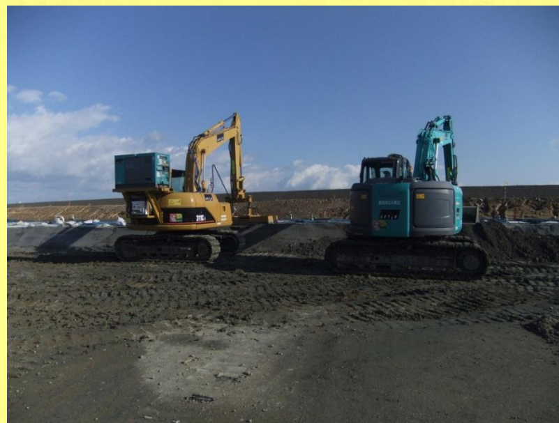
新地町埴浜防災緑地の盛土施工
