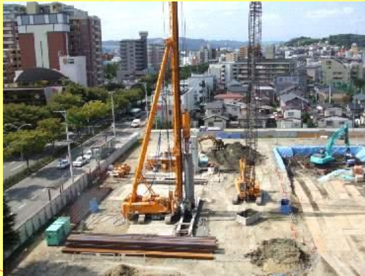
ソイルセメント柱列壁土留め工
