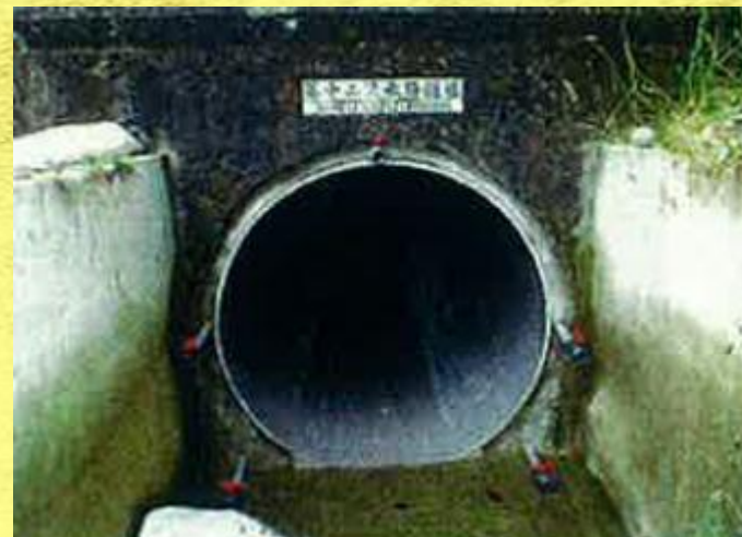
インパイプ中込め工
