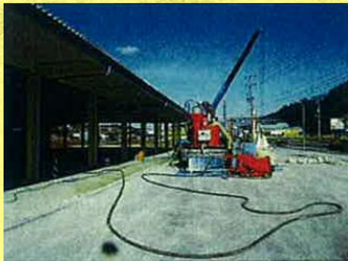
床下空洞充填工
