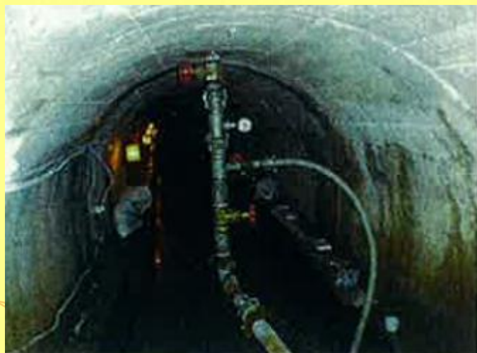
トンネル裏込め工
