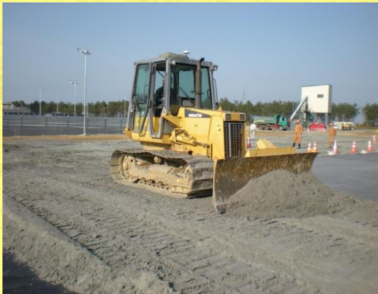
ブルドーザによる撒出し施工
