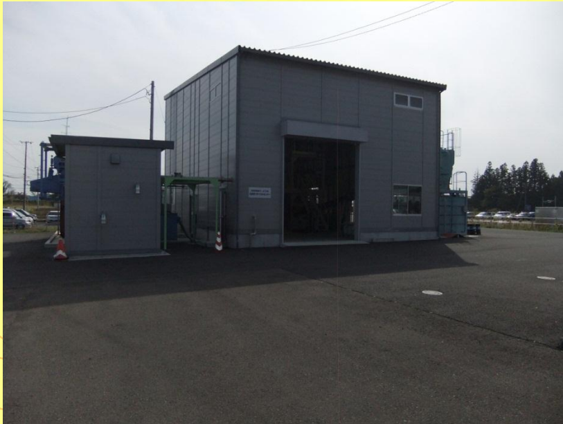
リサイクルプラント全景
