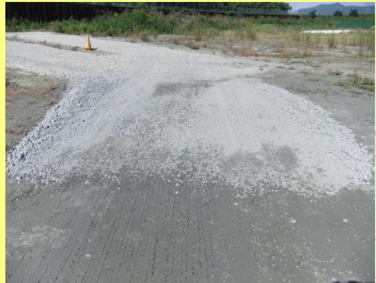
道路路盤材として試験施工
